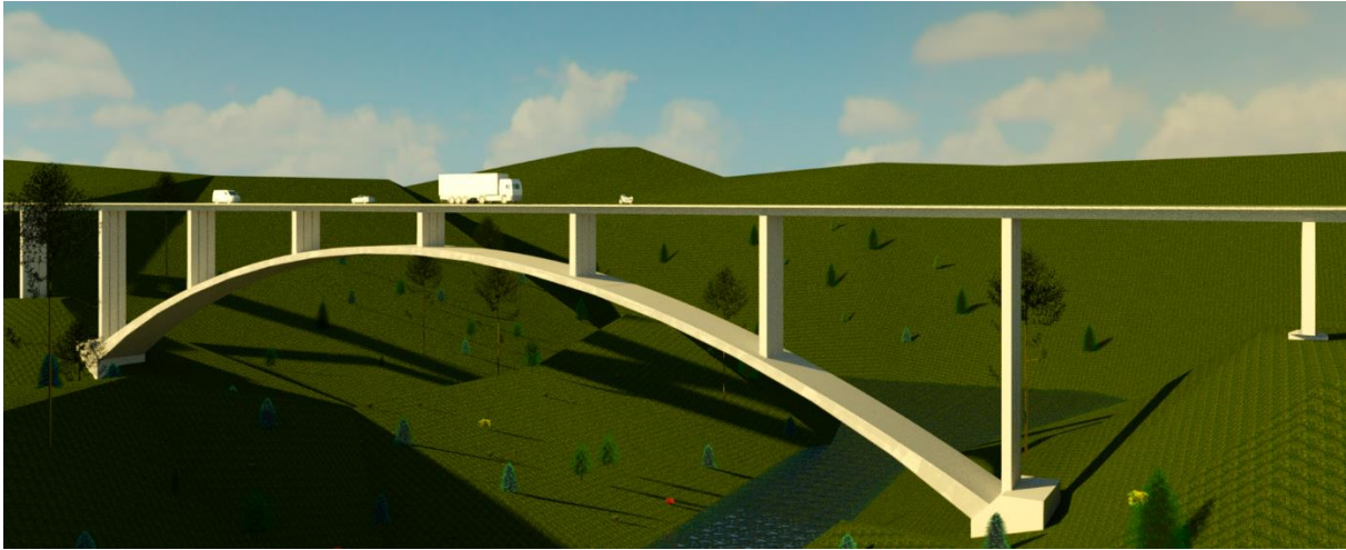
Abbildung 5.5.3: Gerenderte Variante mit langem Einfachbogen derselben Brücke
