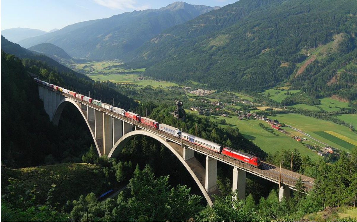
Abbildung 2.4.1: Falkensteinbrücke in Österreich als Beispiel für eine Doppelbogenbrücke (MAPLOGS 2010)
