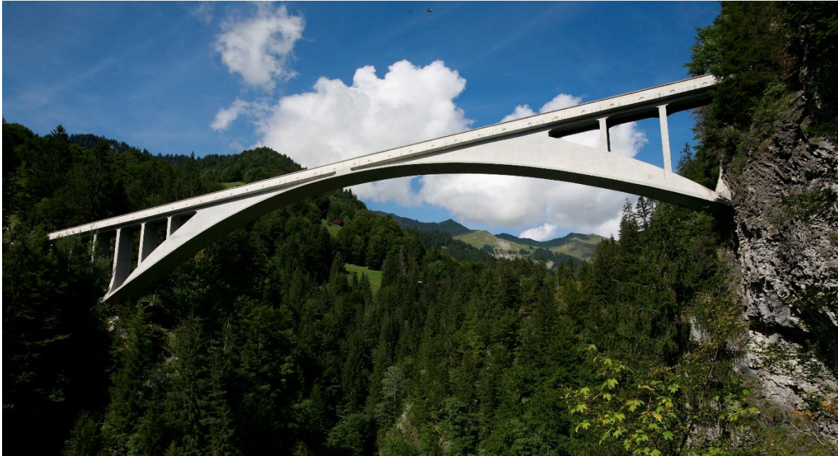
Abbildung 2.3.1: Salginatobelbrücke in der Schweiz von Robert Maillart (Rama 2015)
